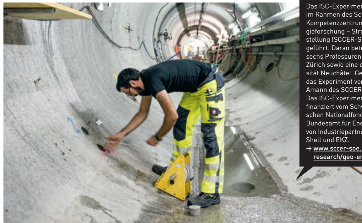
Projektmitarbeiter Reza Jalali führt vorsichtig ein Glasfaserkabel in ein Bohrloch ein.
